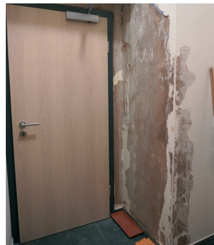
Schaden im Kirchturm.
